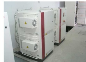
G- Grupo electrógeno diesel 55 kVA
