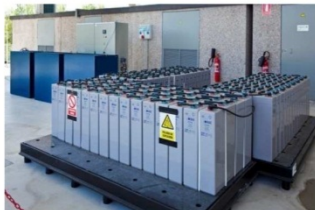
A- Banco de baterías plomo ácido de gel, 50 kW x 2 horas
