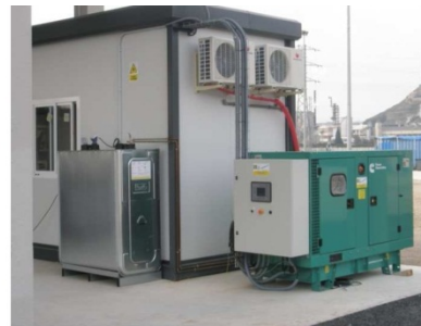
G- Grupo electrógeno diesel 55 kVA
